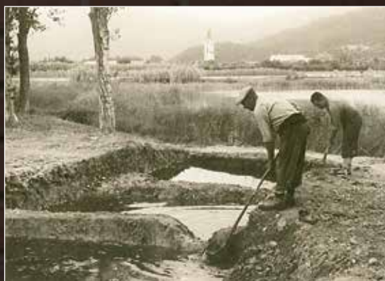
Obres de canalització del recs de Estanyol del Vilar, 1949.
