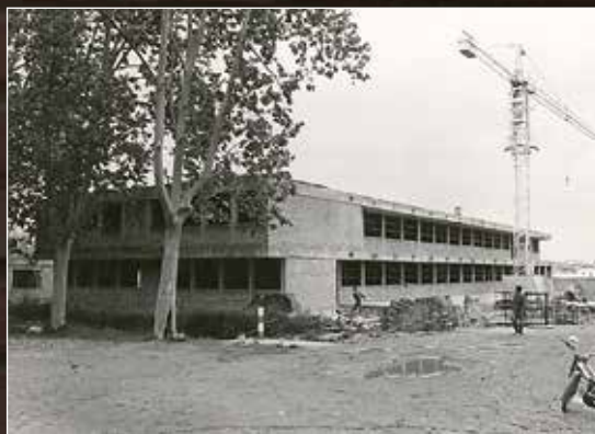
Construcció de L'Institut Pere Alsius, 1968.
