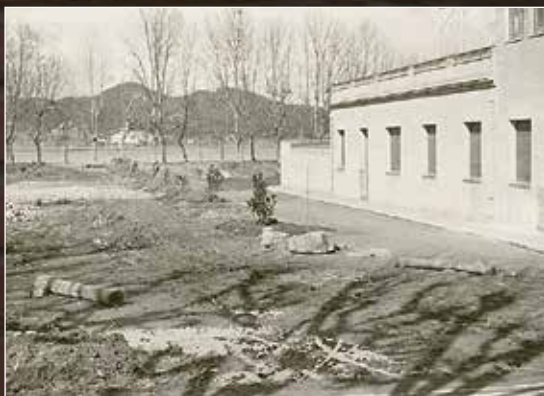
Construcció de l'Edifici de les Aigües de Banyoles, 1955.
