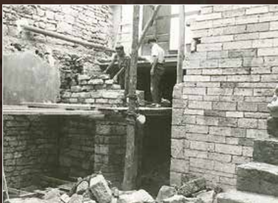
Obres de rehabilitació de l'edifici històric de La Pia Almoina, 1960.
