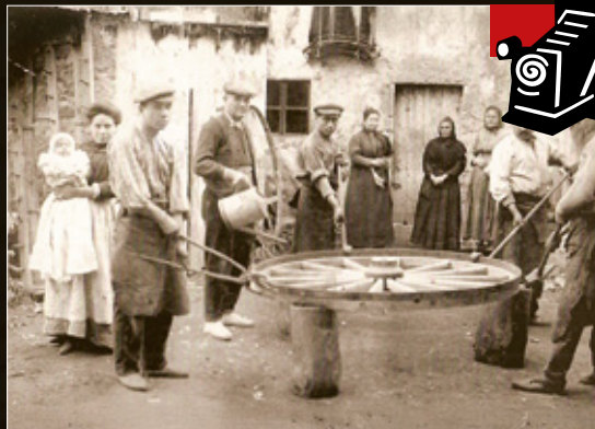
Treballadors al pati de Can Roc de Banyoles, on ferraven rodes. 1912. Foto: ACPE.
