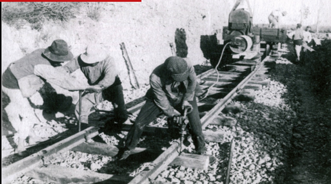
Operaris reparant la via de la línia del tren petit als anys 20.
